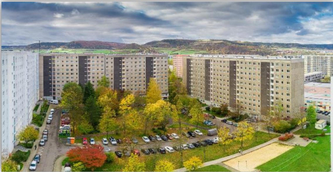
Komplexsanierungsmaßnahme mit Leerzug im zeitlichen Kontext des Projektes
